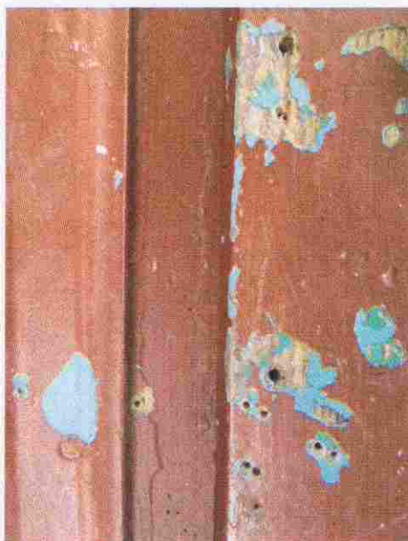
II. 14 fragment drzwi do pomieszczeń sanitarnych
