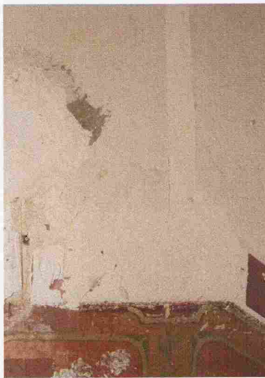
II.10 odkrywka ściany ponad lamperią
