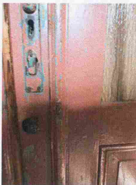
Il. 16 fragment zachowanej stolarki drzwiowej
