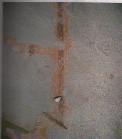
Widoczne pasy oryginalnej malatury ścian
