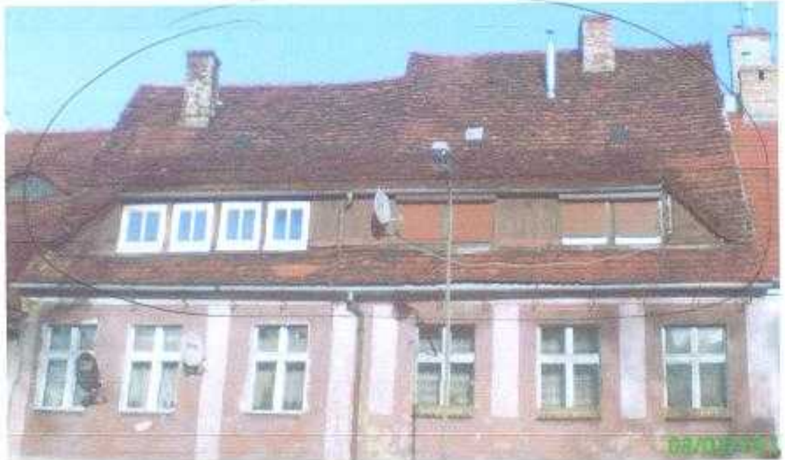
Fot. 1. Widok dachu od ulicy Sikorskiego
