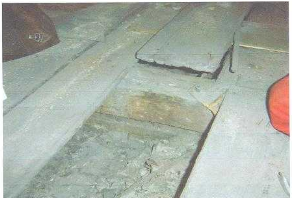
Fot. 2. Odkrywka stropu nad poddaszem użytkowym, widoczna belka stropowa
